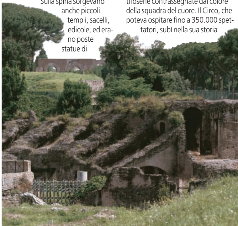
Muri radiales della cavea
